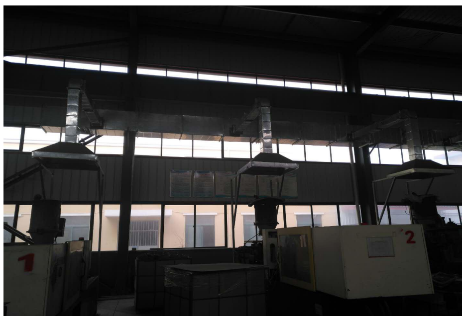
图 4--1-8 注塑成型废气净化设备
