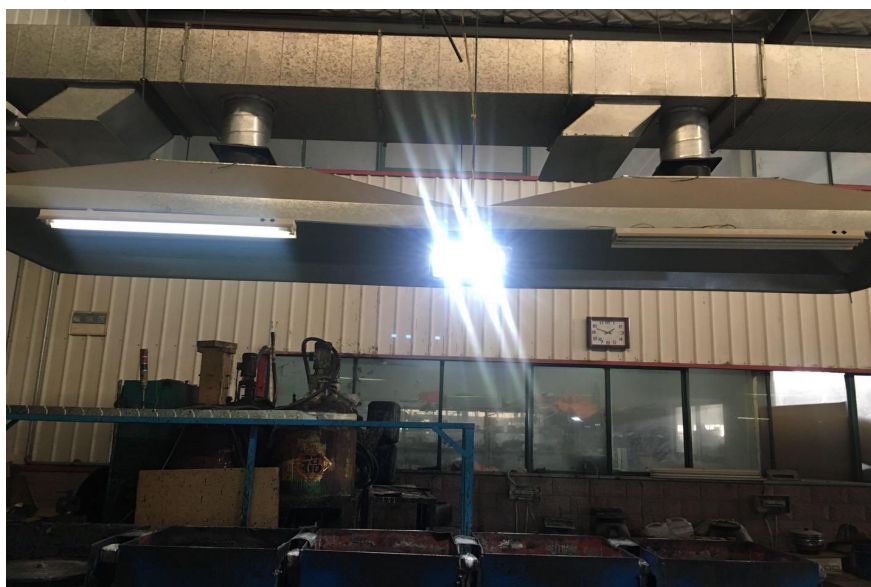
图 4--1-6 PU 轮成型废气净化设备
